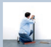
1. Profil ausrichten und anschrauben
